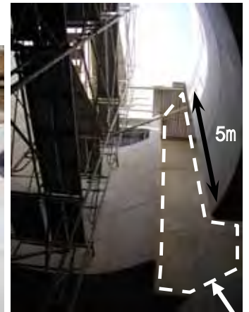
換気立坑坑内 (内径4.5m)
